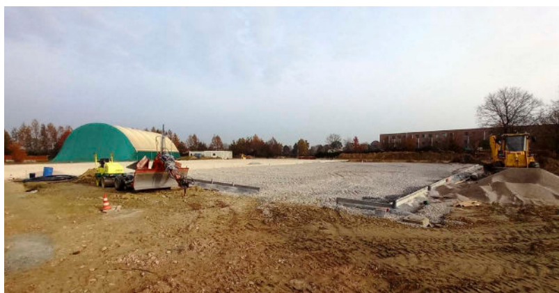
Inizio lavori. Fondamenta e pilastri
