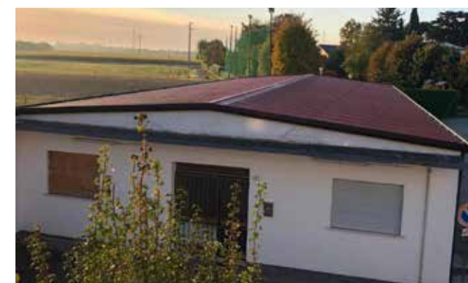
Spogliatoi impianto sportivo Tremignon - dopo l'intervento
