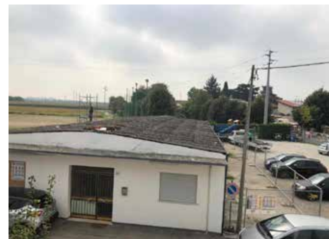
Spogliatoi impianto sportivo Tremignon - prima dell'intervento
